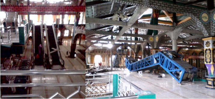
Gambar 8: Tangga eskalator lantai 1 dan sedang dipasang di lantai 2
