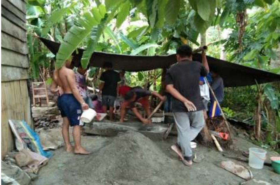
Gambar 5. Gotong Royong Pembangunan WC Ibu Sahara
