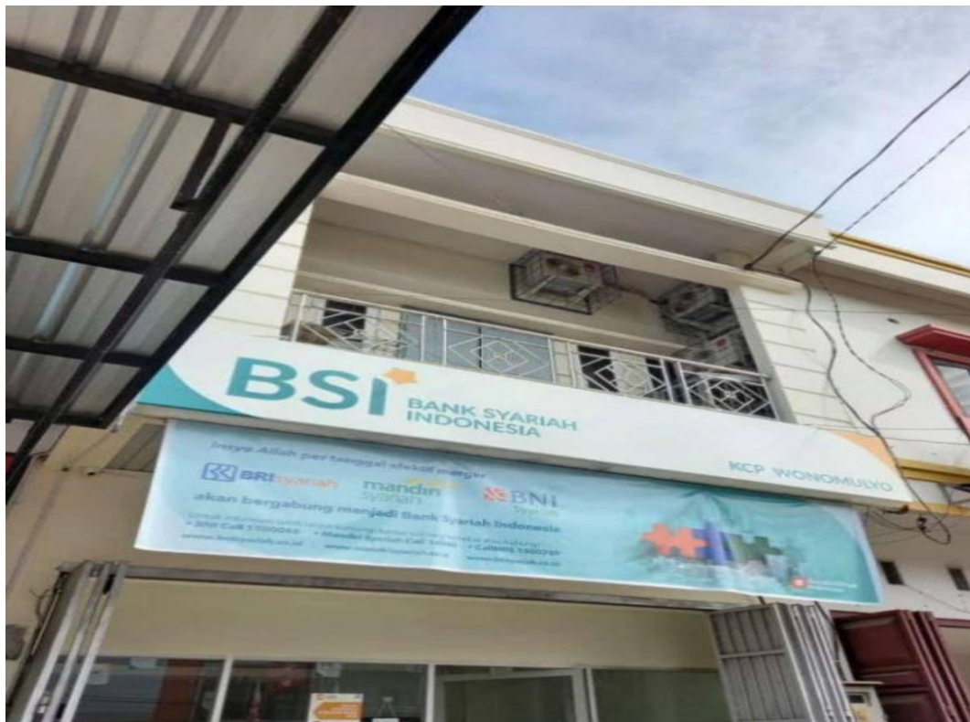
Foto Dokumentasi 4. Bangunan Bank BSI Wonomulyo
